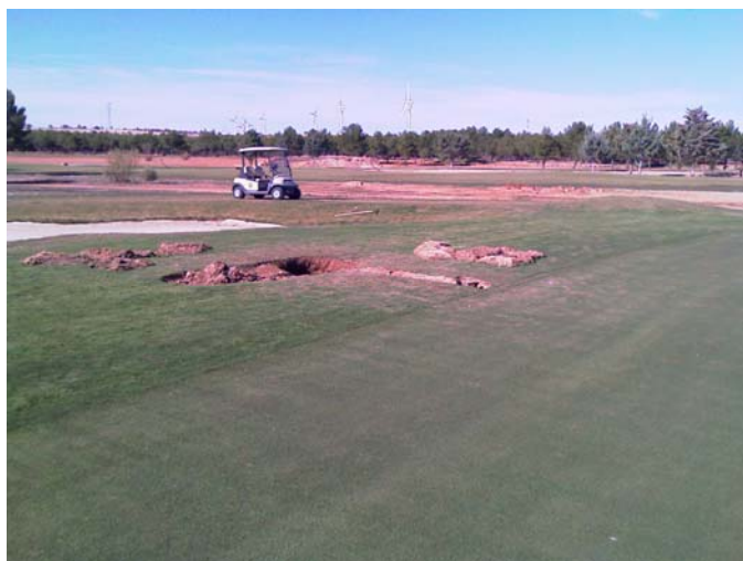
Green hoyo 8, detalle del retranqueo de aspersores.
