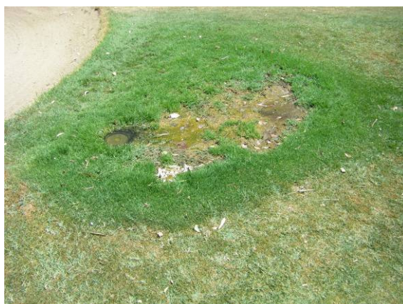
Foto 2. Avería en un aspersor de green.
