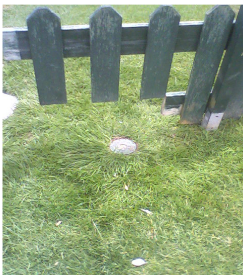
Foto 1. Aspersor del putting green.
