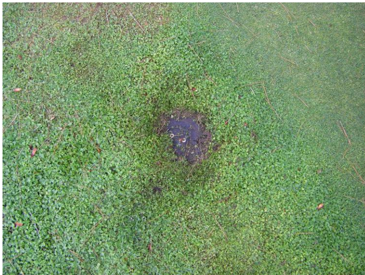
Foto 4. Detalle de un aspersor casi cubierto por el césped.
