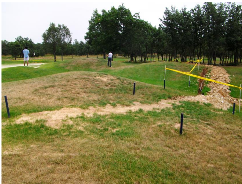
Foto 1.5. Anillo de antegreen que se está construyendo en el 17. En la imagen se puede observar como la cobertura de riego actual es insuficiente para mantener el césped del antegreen
