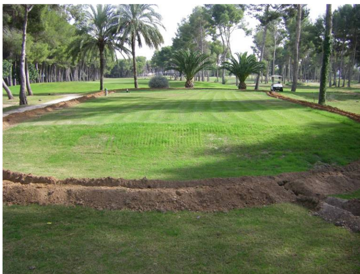
Foto 2. Instalación de un sistema de riego nuevo en un tee del recorrido.
