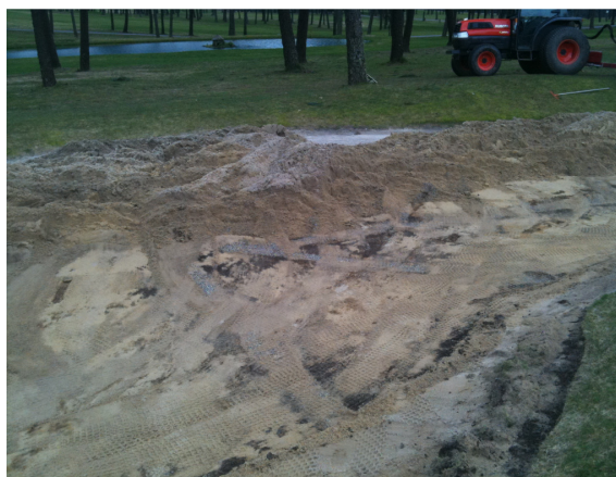
Foto2. Obras acondicionamiento bunkers.
