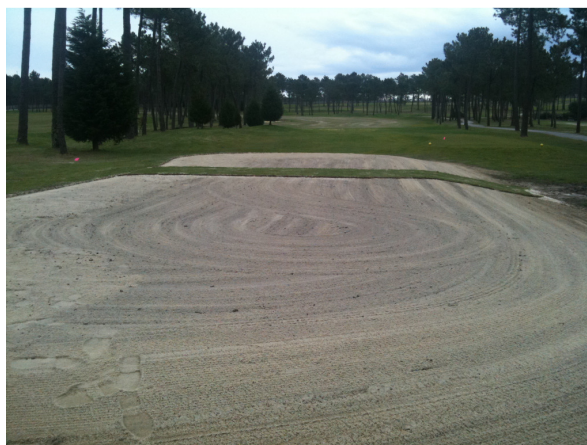
Foto1. Obras ampliación tees.
