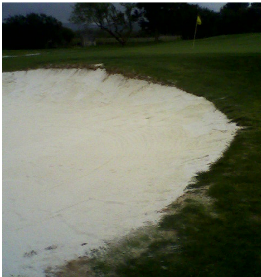
Foto 8. Bunker con la arena nueva.
