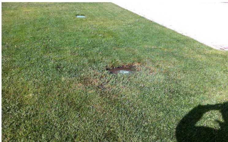
Foto 1.2. Problema de riego en la pradera del parking
