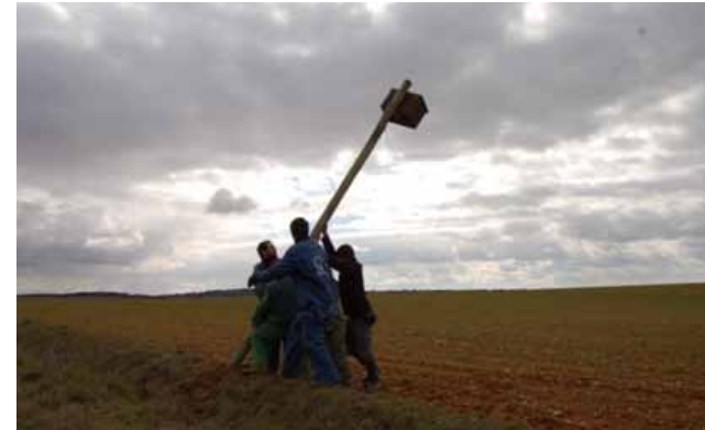
Imagen 5. Instalación de refugios alternativos.
