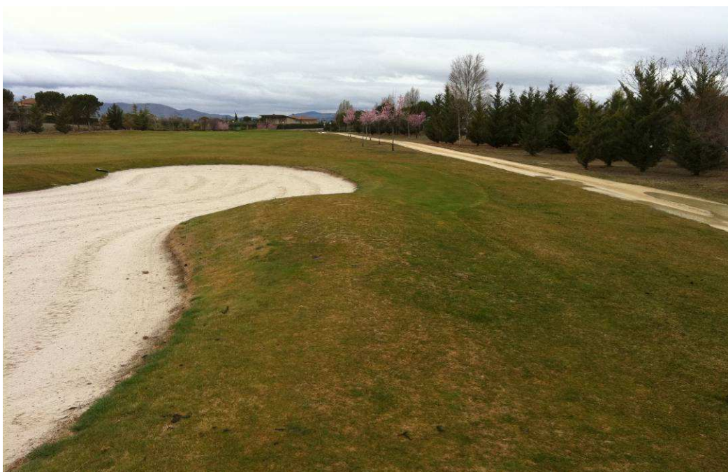
Foto 4.1. Vista del perfilado en bunkers y corte de la zona próxima al mismo
