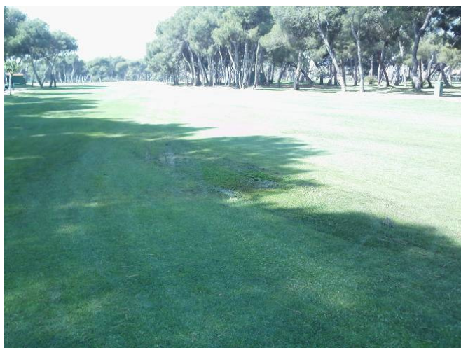
Foto 8. Detalle de una zona con acumulación de agua en la calle #1.
