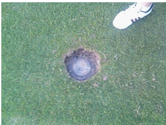
Foto 7. Aspersor con un correcto mantenimiento.
