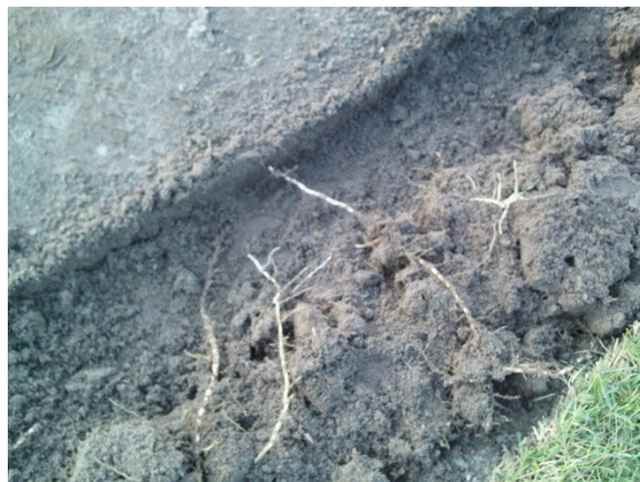
Foto 7. Detalle de los rizomas eliminados durante la retirada de la capa superficial.
