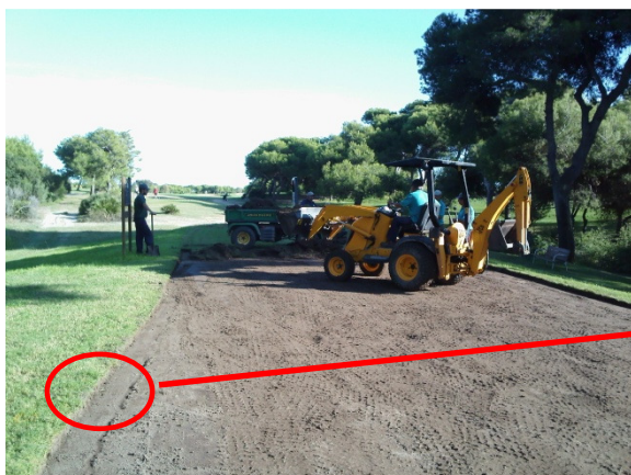
Foto 6. Retirada de la capa superficial.
