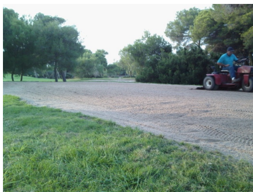
Foto 9. Nivelación de la plataforma.
