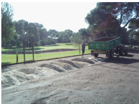
Foto 8. Extendido de la arena.
