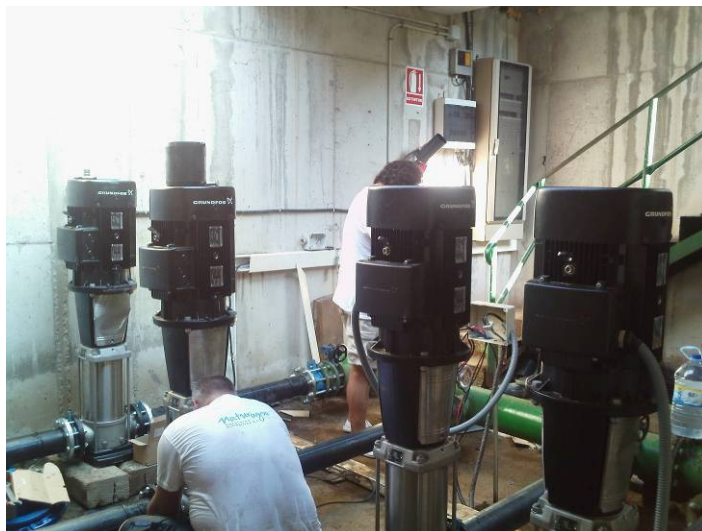
Foto 5. Instalación de las bombas verticales nuevas.
