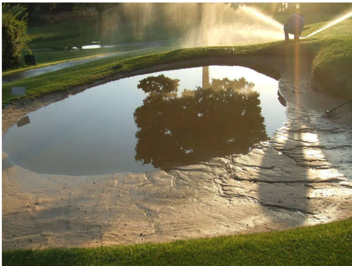
ACUMULACIÓN DE AGUA EN UN BUNKER CAUSADO POR UN ASPERSOR QUE ESTUVO REGANDO TODA LA NOCHE
