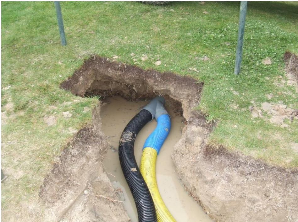
SANEAMIENTO DEL DRENAJE DEL BUNKER DE LA IZQUIERDA DEL HOYO 15
