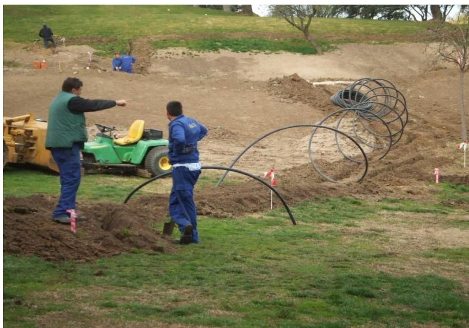
INSTALACIÓN DEL RIEGO EN EL NUEVO PUTTING GREEN
