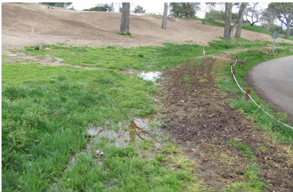
VAGUADA ENCHARCADA EN LA ZONA DEL NUEVO PUTTING GREEN
