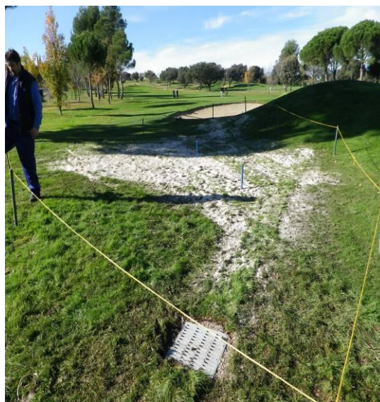
Foto 11. Zona derecha del antegreen del hoyo 2 con el drenaje terminado.
