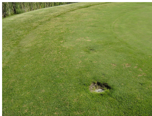
Foto 20. Aspersor hundido
