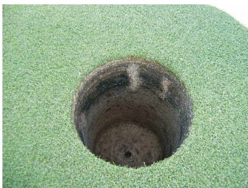
Foto 9. Capas en la cata de un green
