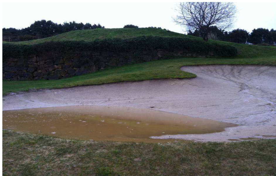
Foto 4.1. Detalle de un bunker y la dificultad de drenaje
