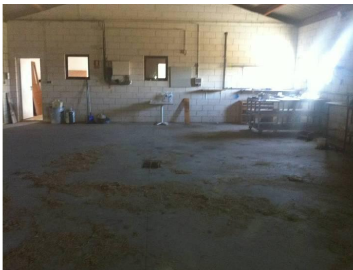
Foto 9. Nave de mantenimiento completamente vacía.
