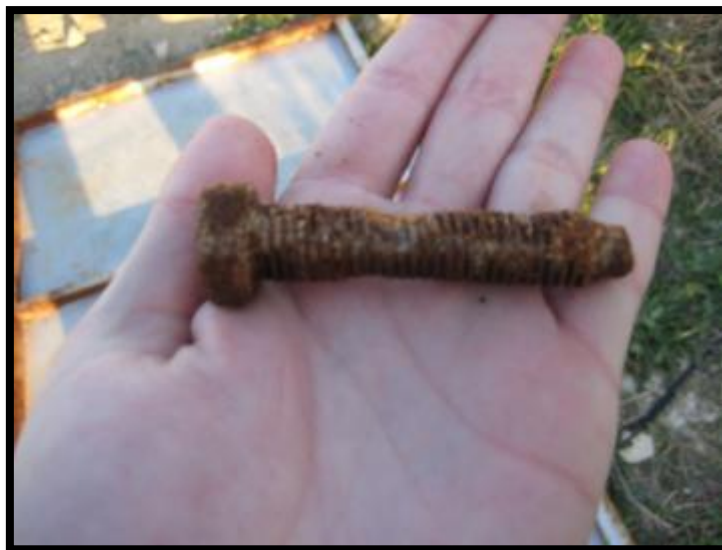
Foto 10. Las bridas y los tornillos de hierro fundido están muy deteriorados.
