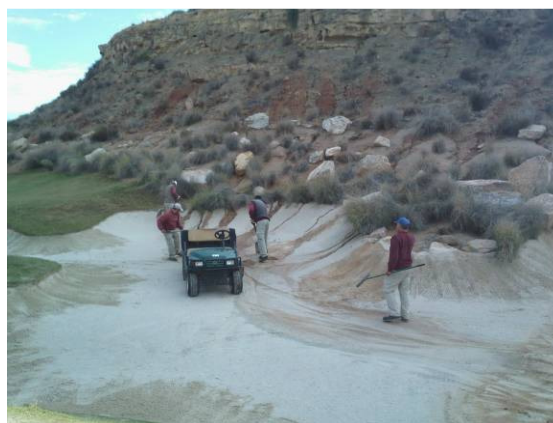
Fotos 6 y 7. Drenaje a mano y trabajos de recuperación de las paredes de los bunkers.
