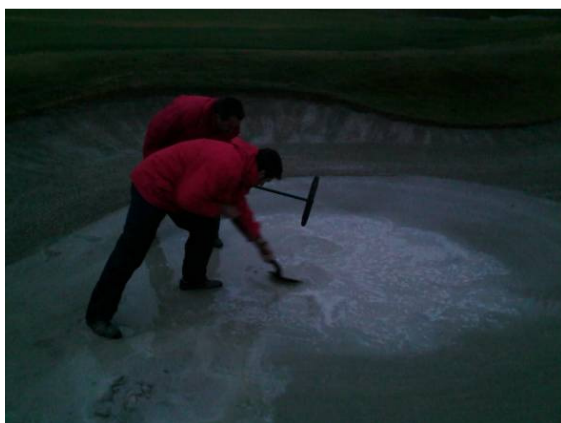
Fotos 6 y 7. Drenaje a mano y trabajos de recuperación de las paredes de los bunkers.
