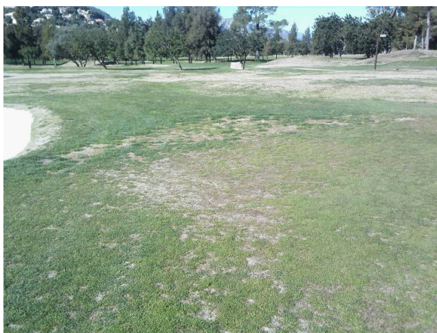
Foto 8. Detalle de zona compactada debido al tráfico en la salida del green # 10.
