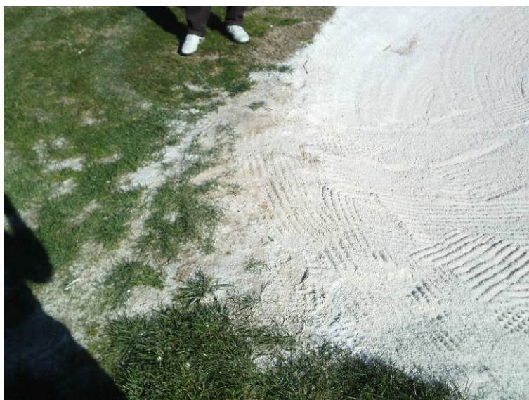
Foto 7. Detalle de la pérdida de definición de un bunker debido a la salida y entrada de la moto de bunkers.
