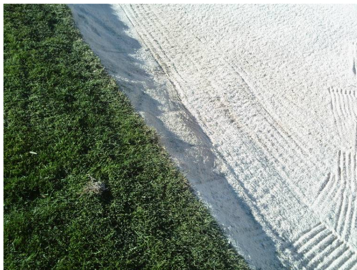
Foto 5. Detalle del perfilado y de la nueva arena de los bunkers de La Sella Golf.
