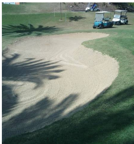
Foto 10. Detalle del perfilado de un bunker.
