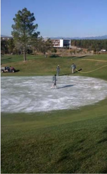
Gypsum green: aplicación de 2000kg/ha de Sulfato de Calcio en un Green para liberar sodio y mejorar la infiltración
