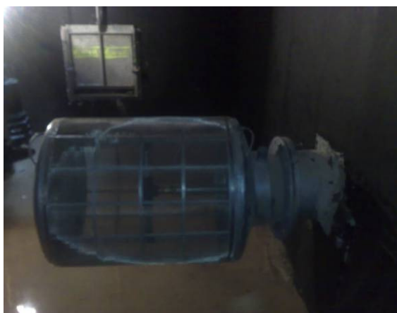
Foto 6. Filtro con autolimpiado para la aspiración.
