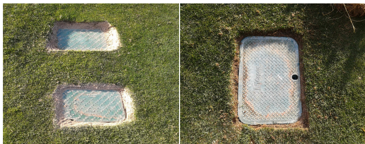
Limpieza y localización de electroválvula e hidrantes (Foto 1.1)
