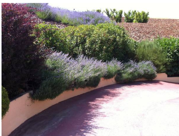
Foto 5. Detalle del estado actual de la rampa de salida y entrada de buggies. La zona derecha ha de ser vigilada para que no estreche la rampa.
