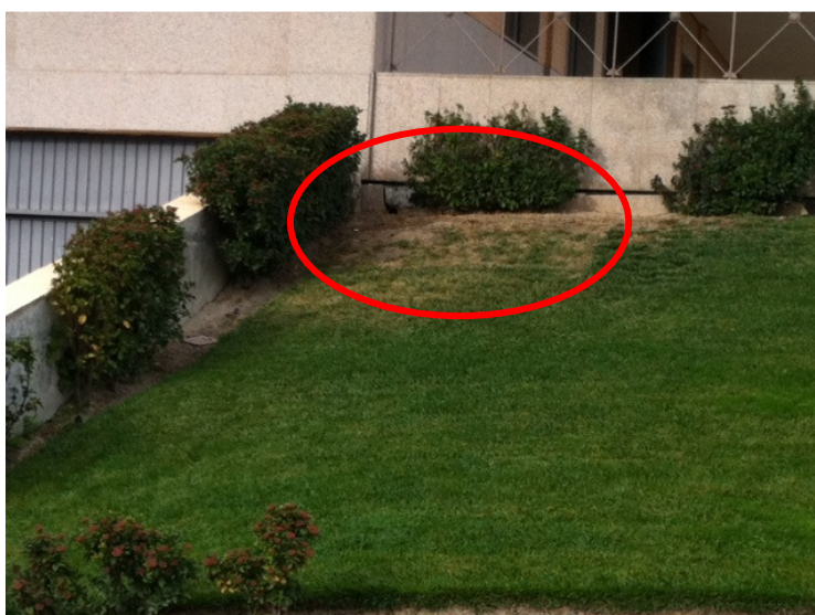
Foto 2. Zona con una posible avería de riego.
