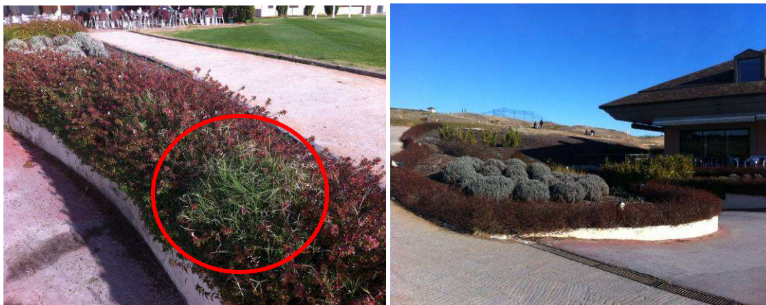
Foto 2.1. Vista de parterres de la rampa de bajada a Caddy Master
