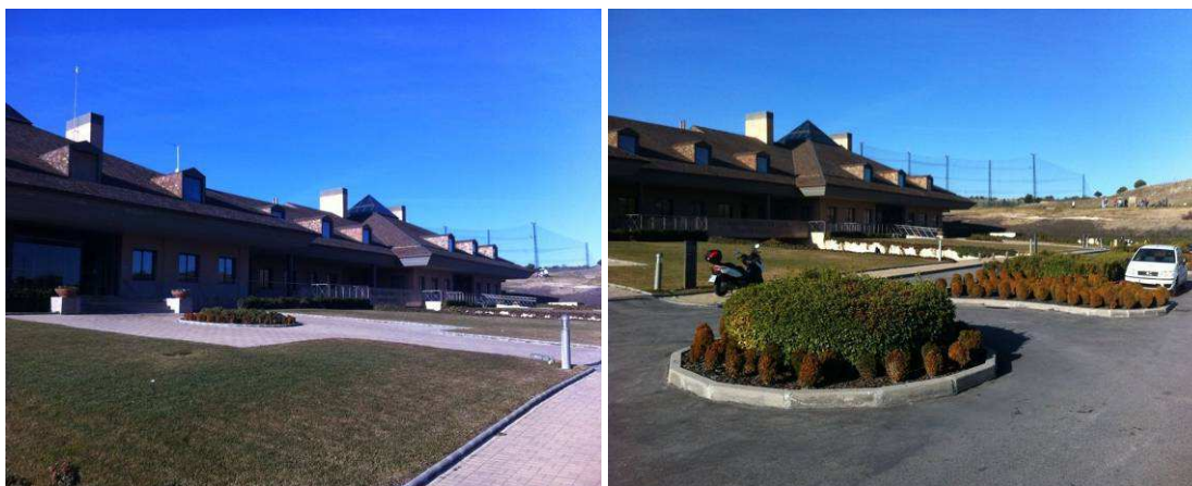
Foto 1.1. Vista de la pradera del parking
