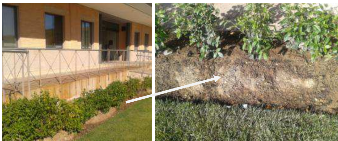
Vista labor de drenaje realizada en los durillos
