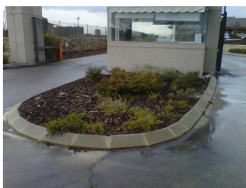
Parterre de acceso al recinto
