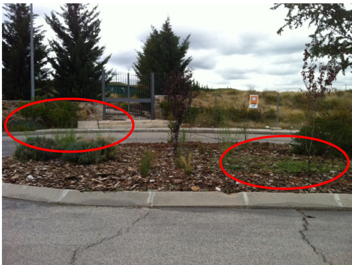
Foto 3. Estado actual del parterre de la entrada, donde se pueden observar malas hierbas.
