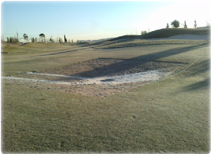
Drenaje finalizado. 150 m2 de tepes utilizados
