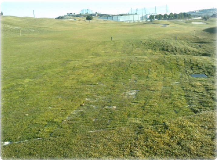
Drenaje realizado. 200 m2 de tepes utilizados
