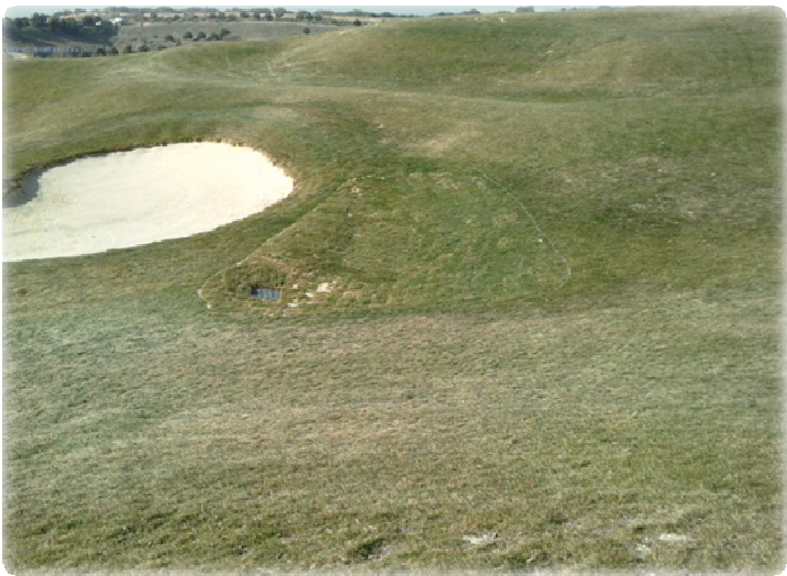
Drenaje realizado.90m2 e tepes utilizados
