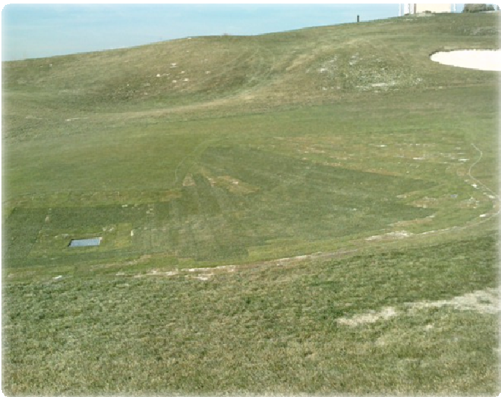
Drenaje ya realizado. 150 m2 de tepes utilizados
