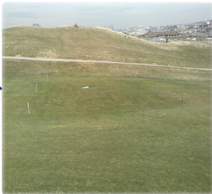
Drenaje ya realizado. 90 m2 de tepes utilizados
