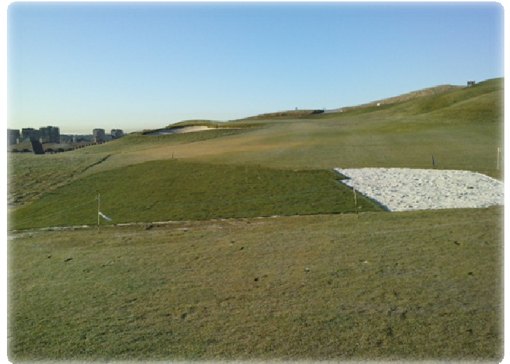
Drenaje finalizado. 200 m2 de tepes utilizados
