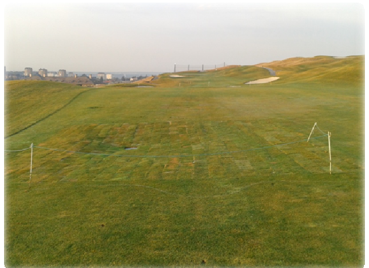
Drenaje realizado. 90 m2 de tepes utilizados.
