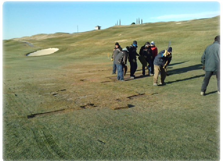
Drenaje realizado. 170 m2 de tepes utilizados
