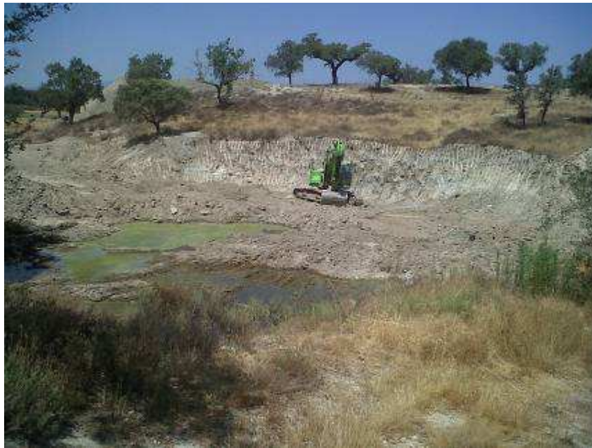
Foto. Maquina realizando los trabajos de lago hoyo 18.
