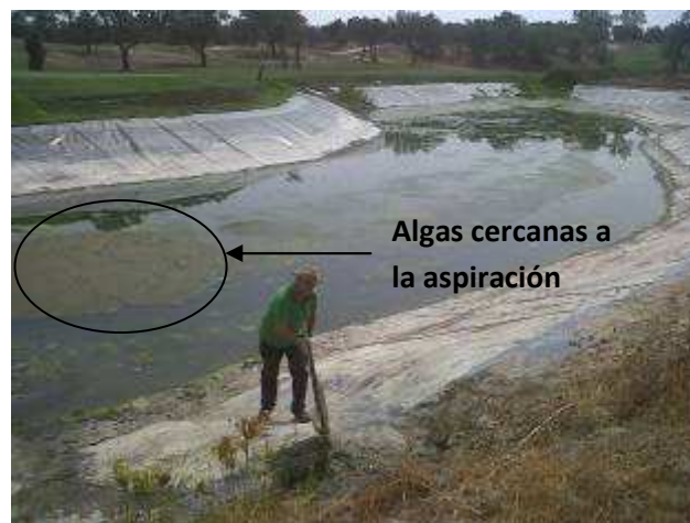
Foto 2. Operario retirando algas de la aspiración.
