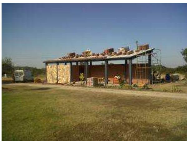
Foto 7.1 Situación actual de las instalaciones.
