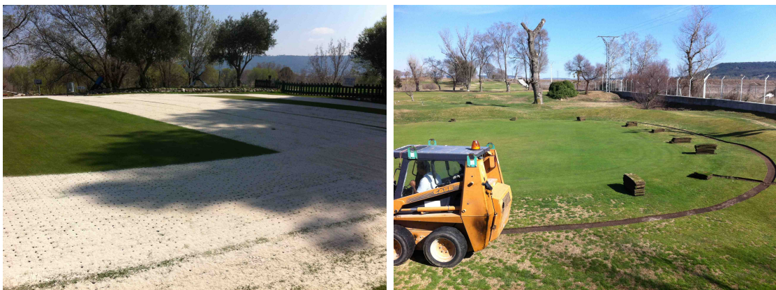
Foto 1: Detalle de Putting Green pinchado y recebado, y obra de riego en Green 2, respectivamente.
