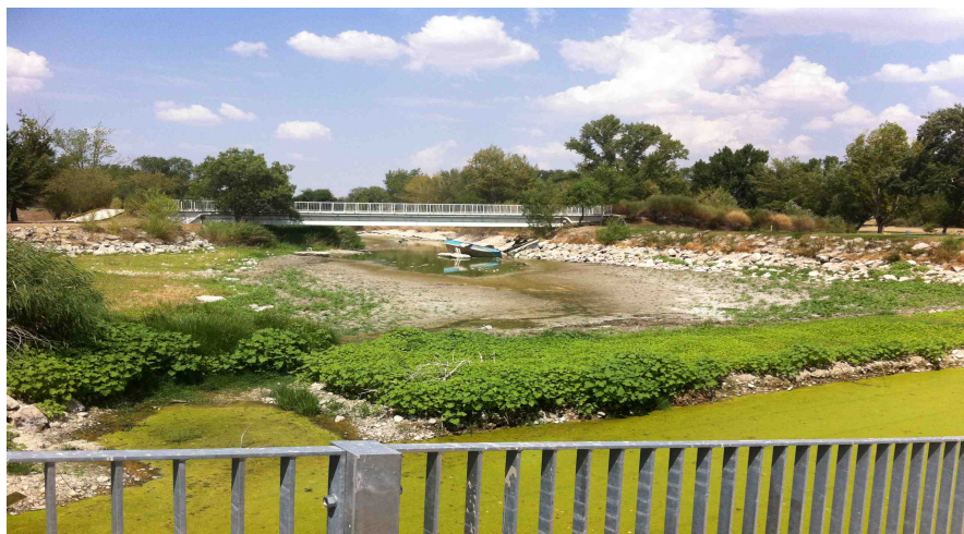
Foto 1: Detalle actual del río Torote (Principal suministro de agua del campo)
