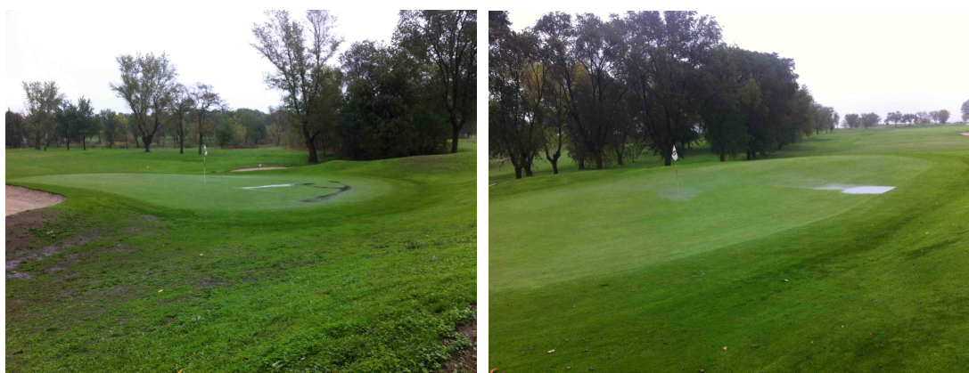
Foto 1: Detalle del encharcamiento de los greens tras periodos de lluvia.
