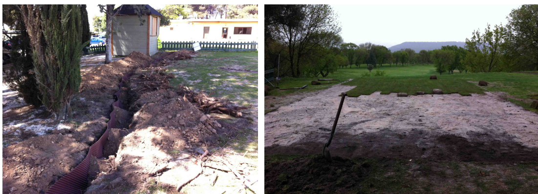
Foto 4: Detalle de zanja perimetral y tepeado en el Tee 1, respectivamente.
