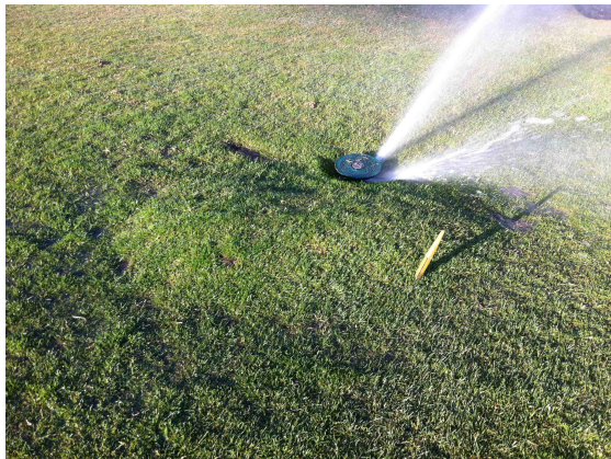
Foto 3: Detalle del mal estado de los aspersores F 51 (Izq) y de la disparidad en cuanto a tipos de aspersores que hay en una misma superficie (Dcha.) Nótese en la foto de la izquierda como el aspersor, al estar tan bajo con respecto al terreno, inyecta el agua en el perfil del suelo.
