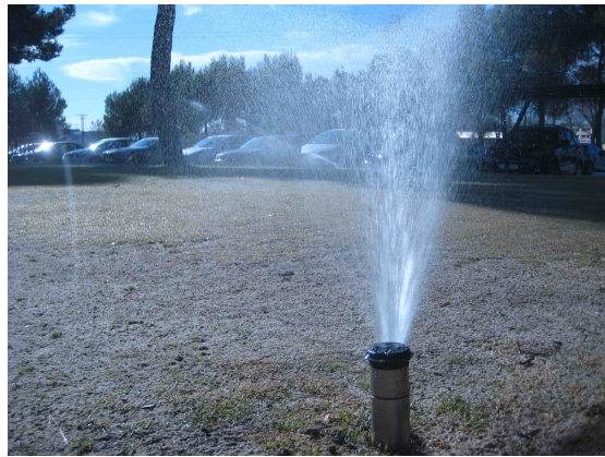
Foto 3: Detalle del mal estado de los aspersores F 51 (Izq) y de la disparidad en cuanto a tipos de aspersores que hay en una misma superficie (Dcha.) Nótese en la foto de la izquierda como el aspersor, al estar tan bajo con respecto al terreno, inyecta el agua en el perfil del suelo.
