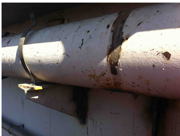
Foto 4: Detalle del tramo de la tubería general en acero galvanizado.
