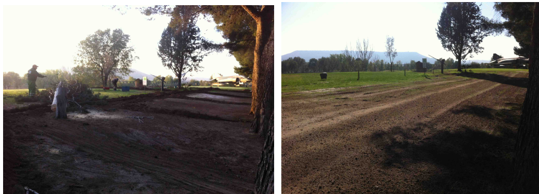
Foto3: Detalle de la apertura de zanjas y de la finalización del proyecto de la casa club.
