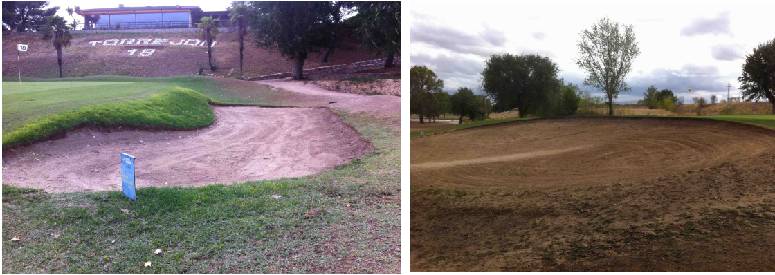
Foto 10: Detalle de la escasa cobertura vegetal alrededor de los bunkers
