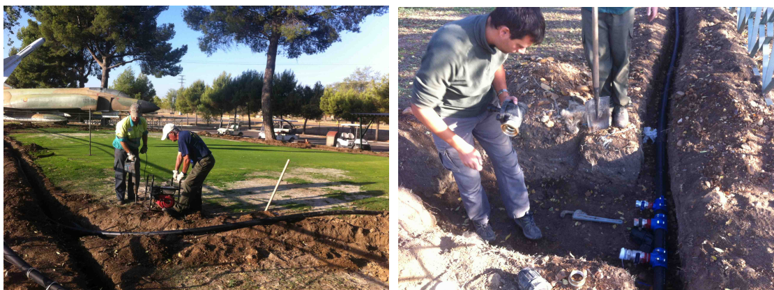
Foto 4: Colocación de anillo de green en el Putting green (Izq) e instalación de válvulas (Dcha)
