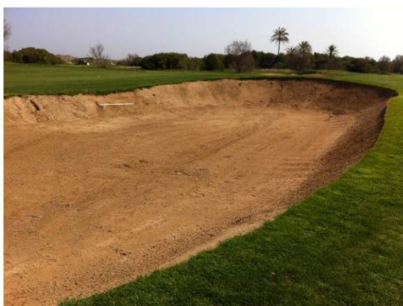
Foto 7. Estado que presentaban los bunkers. Se puede observar la poca cantidad de arena que hay en la base de los bunkers.
