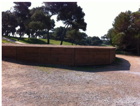
Foto 3. Nuevo cajeadado del tee #1.
