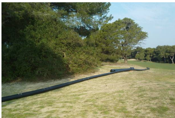
Foto 11. Tubería dispuesta para ser instalada.
