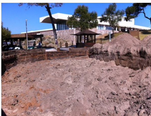
Foto 4. Tee de amateurs del #1 en pleno proceso de renovación.
