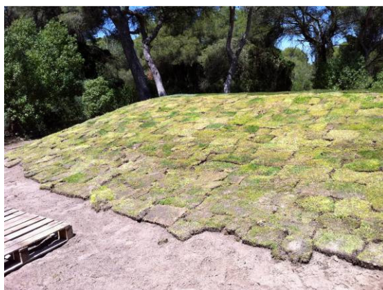
Foto 3. Talud trasero de la plataforma de tee #4 tepeado con tepes reutilizados.
