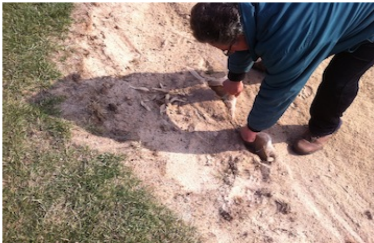
Foto 8. Geotextil del bunker en la superficie
